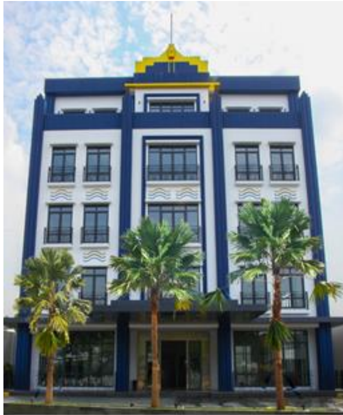
(Gambar Gedung Grh@ HRH yang berlokasi di Lebak Bulus – Jakarta Selatan)
